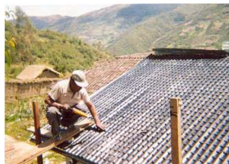
Fotografía N° 08: Prototipo con difusores de mortero de cemento espaciados cada 5 cm
