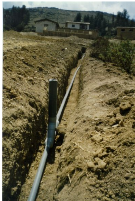
Construcción de buzón
