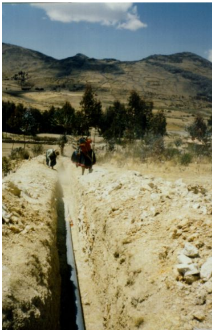
Tendido de red colectora
